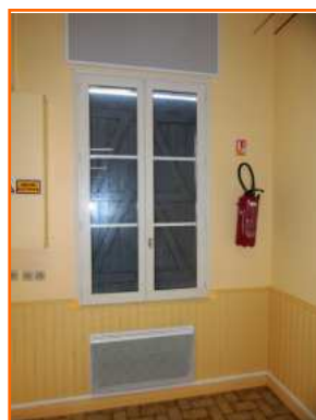
Remplacement des doubles vitrages sur 3 fenêtres de la salle des fêtes et 2 fenêtres de la 3 classe pour des problèmes de joint d'étanchéité par l'entreprise Robichon : 1 555 €
